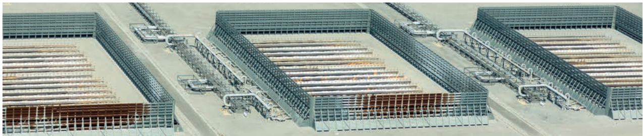
Ground flares at Cameron LNG site
